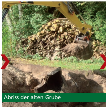
Aushub für Mehrkammergrube
